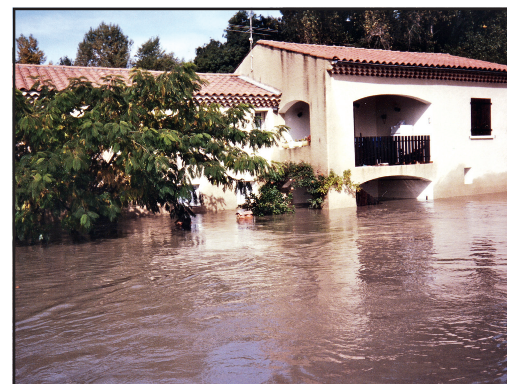
Maison DUGLOU et ses repères de crues.
